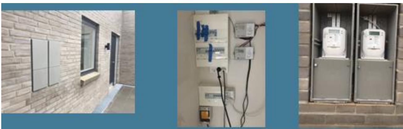
Figur 7. Bi-elmåler til varmepumpen i Silkeborg.
