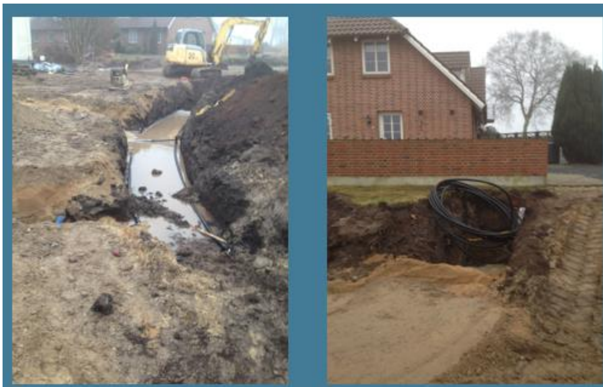
Figur 8. Rørgraven i Silkeborg.
